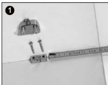
Montering med kopplingsbeslag
